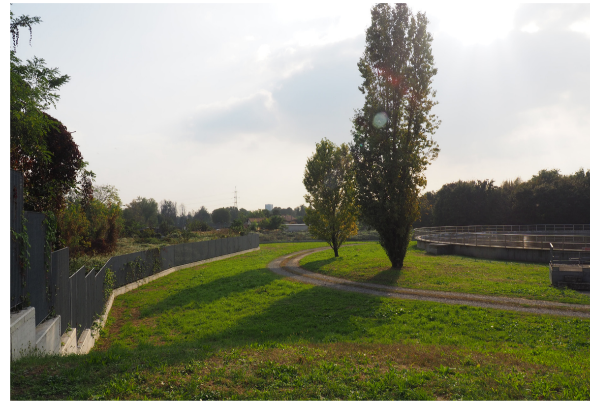
10_La recinzione CAP che a sud dell'argine del Lambro si raccorda al piano di campagna più basso
