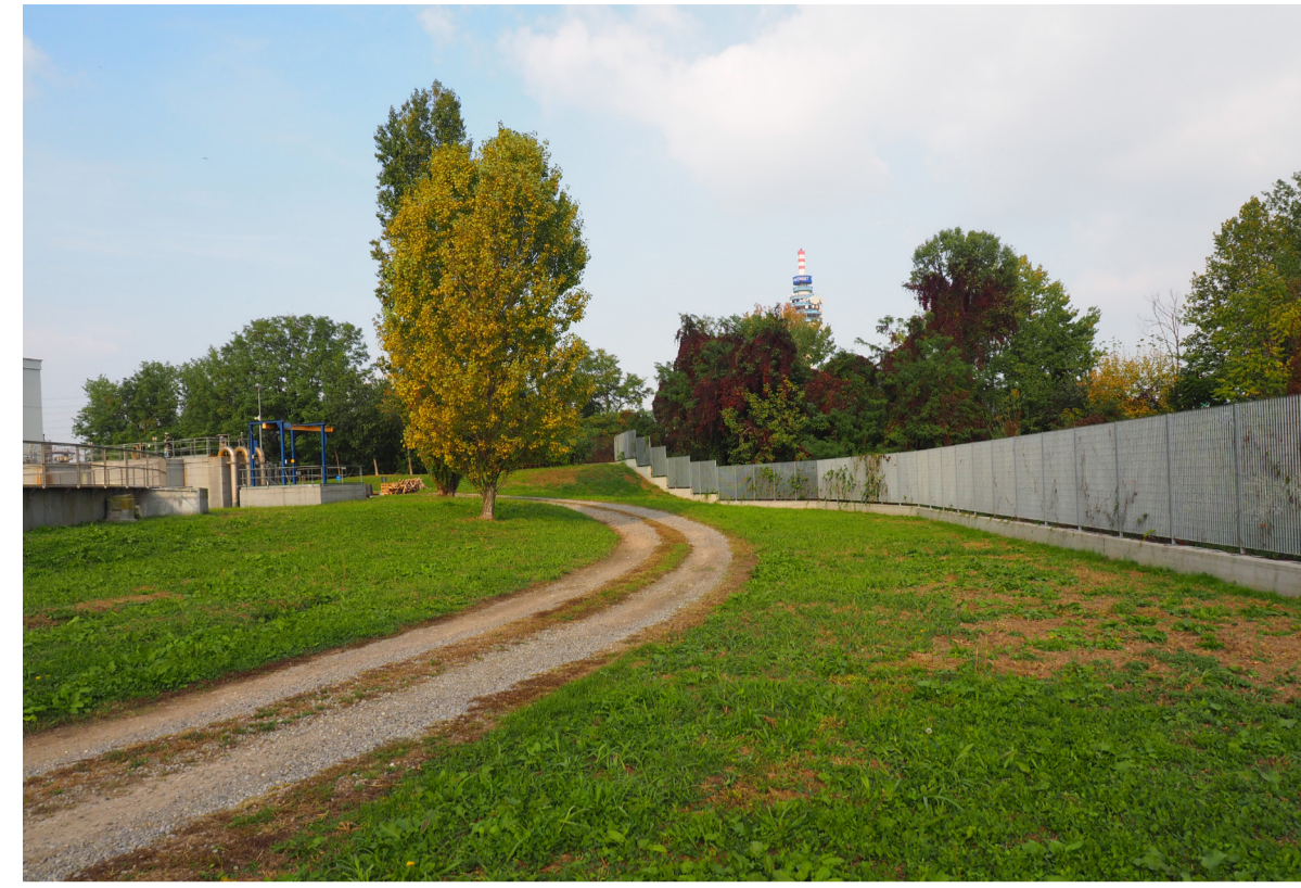
9_La recinzione CAP a sud in prossimità dell'argine del Lambro
