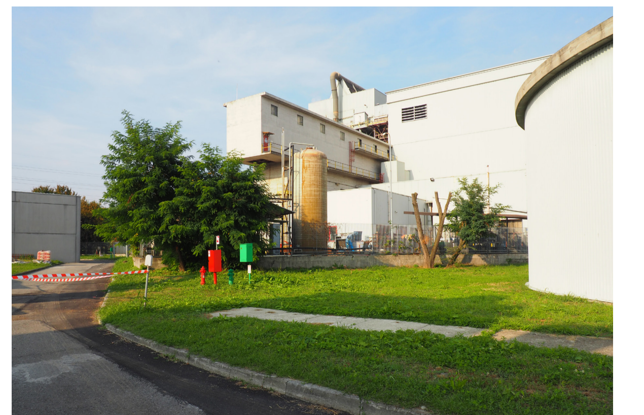
16_L'edificio delle fosse e la sala impianti CORE visti dall'area CAP
