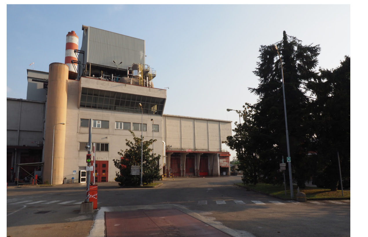
15_ L'edificio delle fosse e il volume dei servizi e la sala controllo
