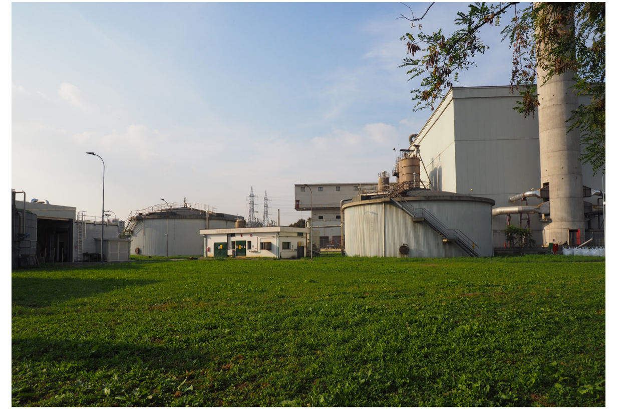
13_L'impianto CAP visto da sud
