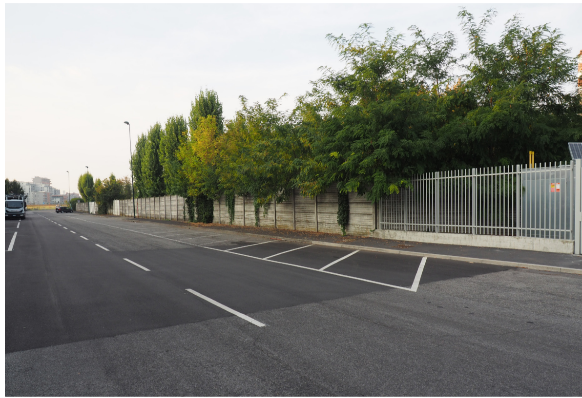
4_La recinzione CAP su via Menin, sud ovest
