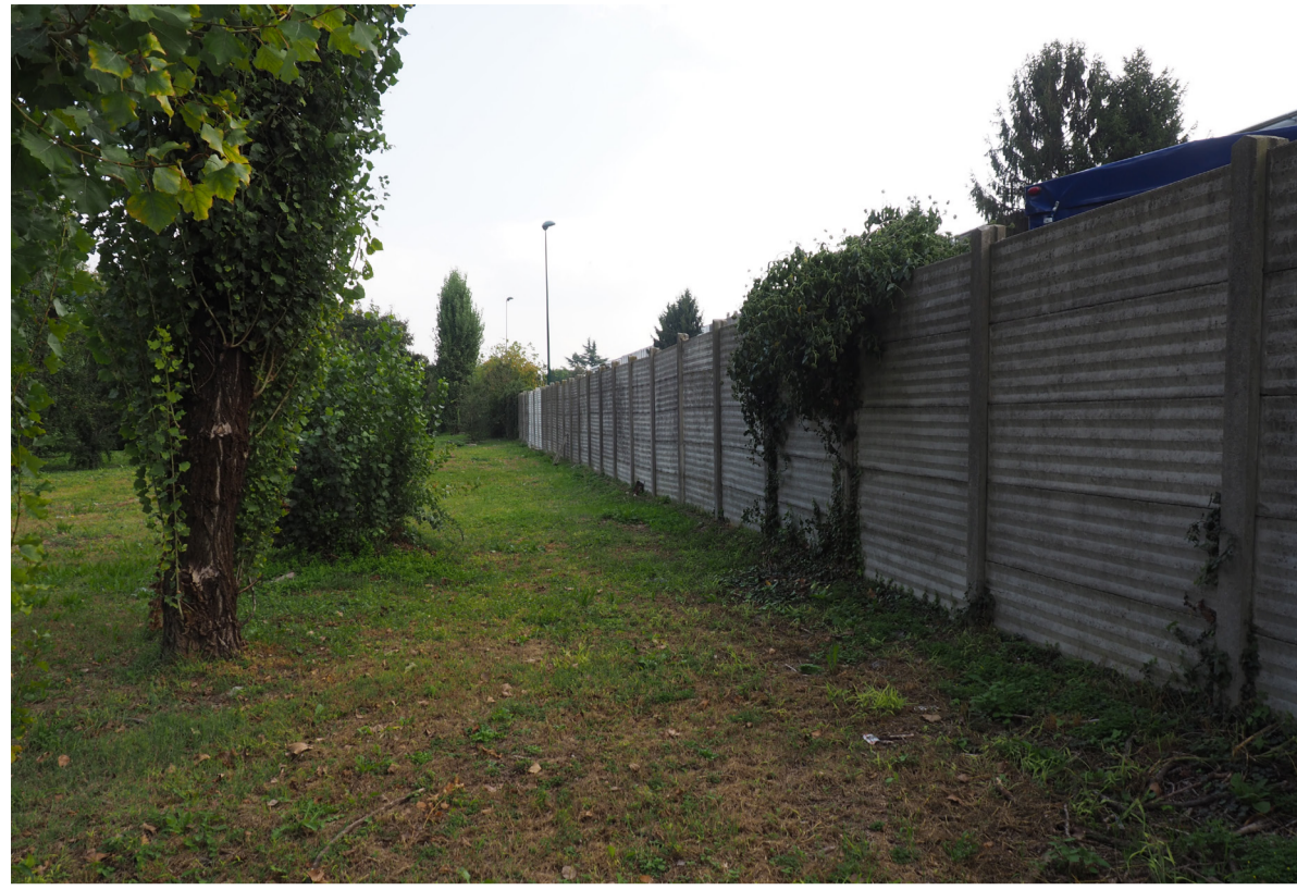
3_La recinzione CAP su via Menin a Sud ovest vista dall'interno
